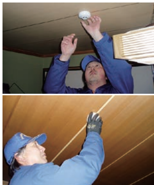
消防団員による取付け風景
