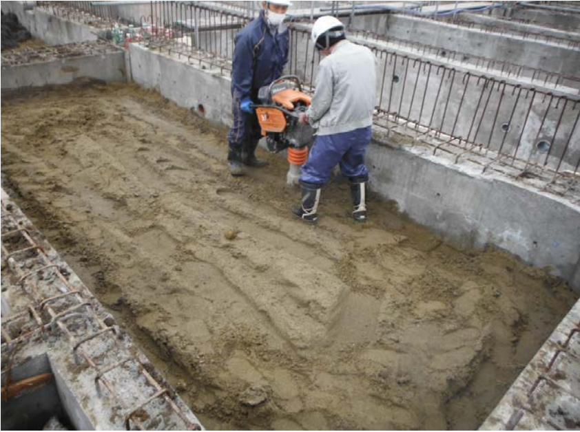
2016年3月 庁舎棟埋戻し、転圧状況
