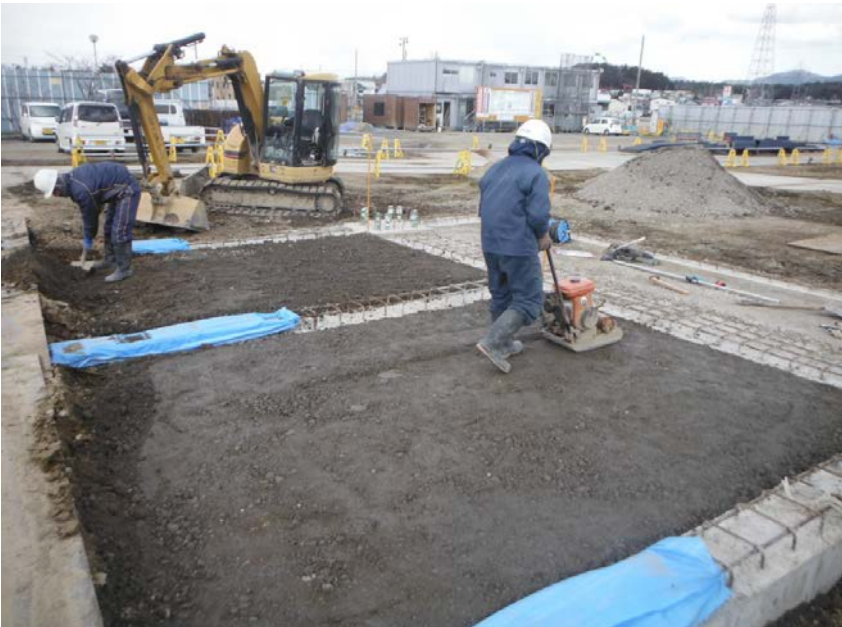
2016年3月 庁舎棟碎石転圧状況
