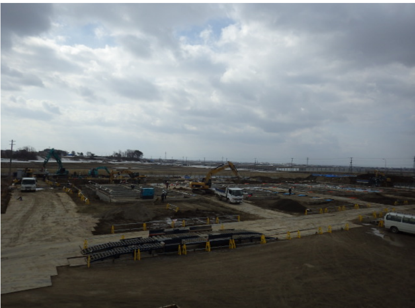
2016年3月 新庁舎建設現場全景
