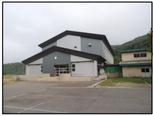
小泊中学校体育館
