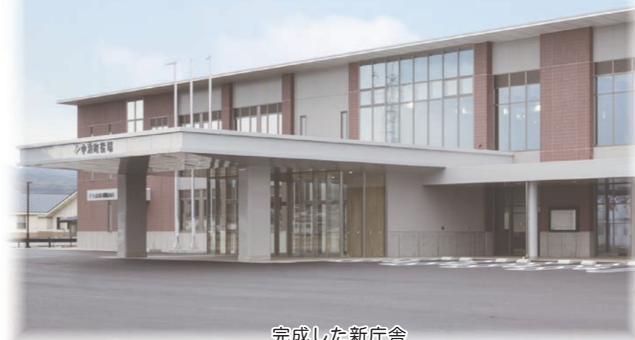
完成した新庁舎
