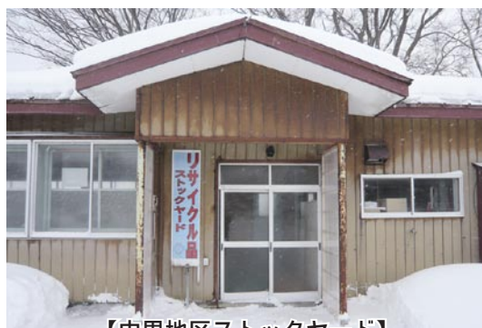
【中里地区ストックヤード】
