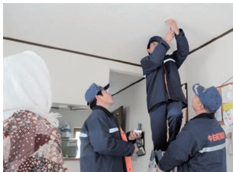
【ボランティアによる取付風景】
