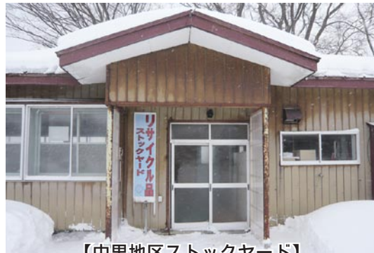
【中里地区ストックヤード】
