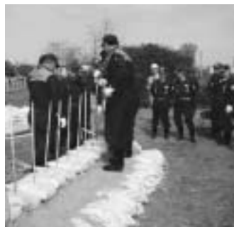
【積土のう工法】
