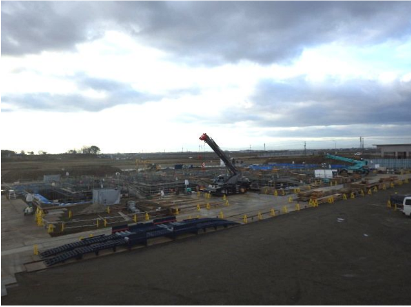
2015年12月2日 新庁舎建設現場全景
