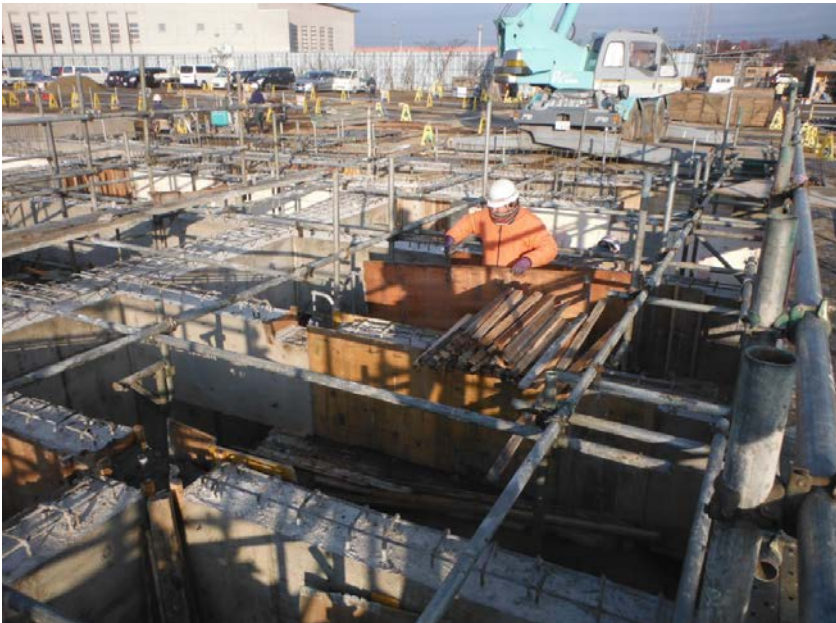
2015年12月19日 基礎枠解体状況
