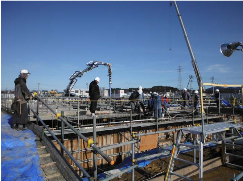
2015年12月14日 基礎コンクリート打設状況
