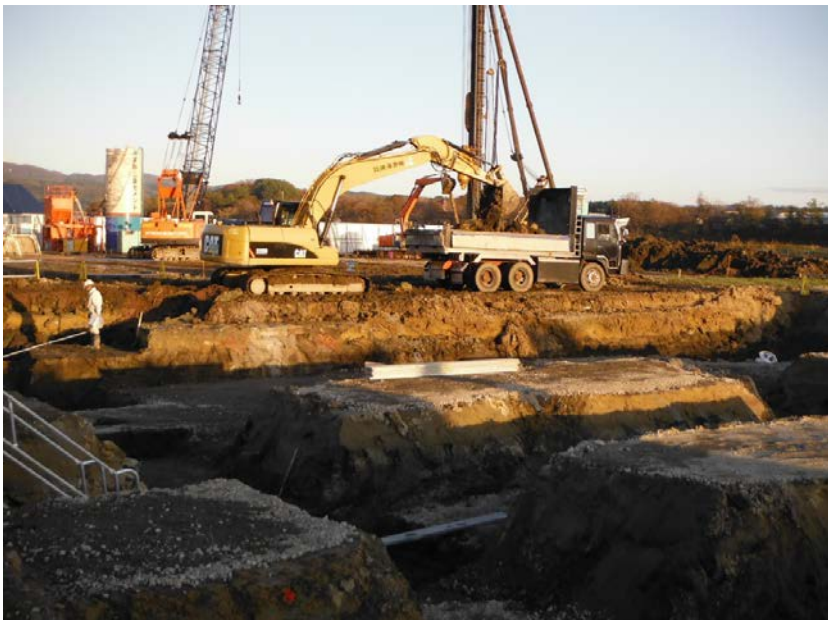
2015年10月22日 庁舎棟掘削工事の状況
