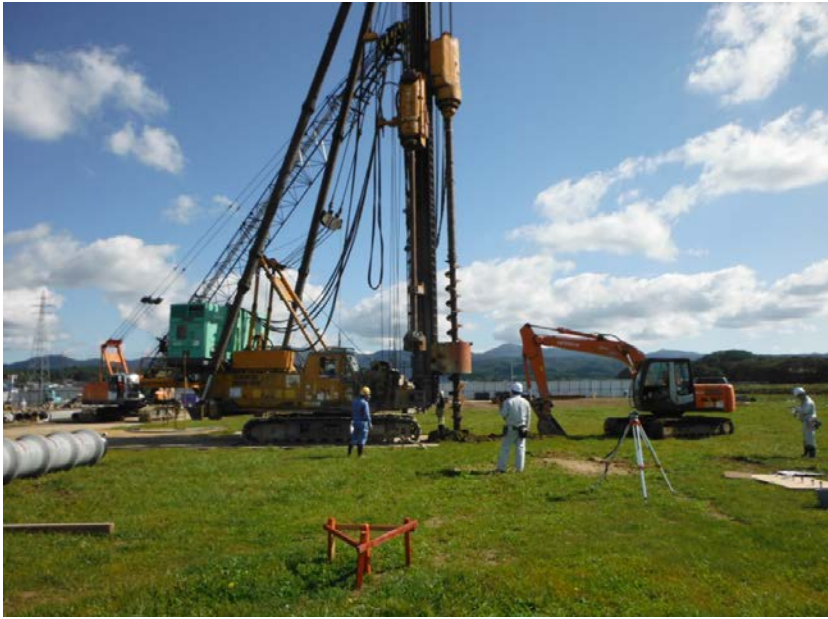
2015年10月7日 杭打ちの工事を開始しました。
