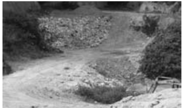
中里一般廃棄物最終処分場 中泊町大字尾別字尾別山1番地5 中泊町大字尾別字小谷291番地1 ☎57 - 4963
