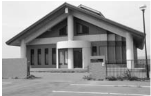
豊岡地区農業集落排水処理施設 中泊町大字福浦字若野尾215番地4 ☎57 - 9171
