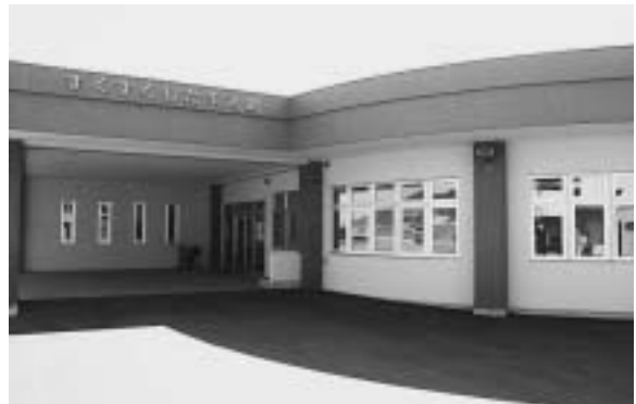
すくすくしたまえ館 中泊町大字小泊字下前207番地 2 ☎64 - 2266
