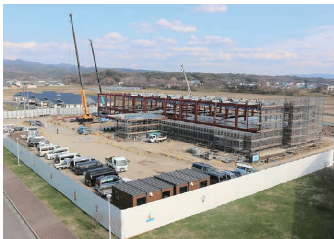
役場新庁舎建設現場
