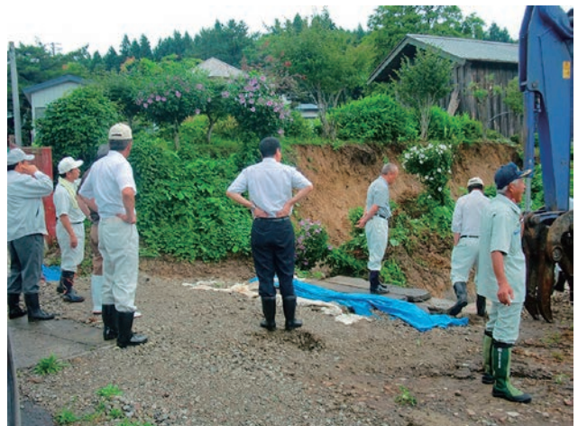
宮野沢土砂崩れ状況
