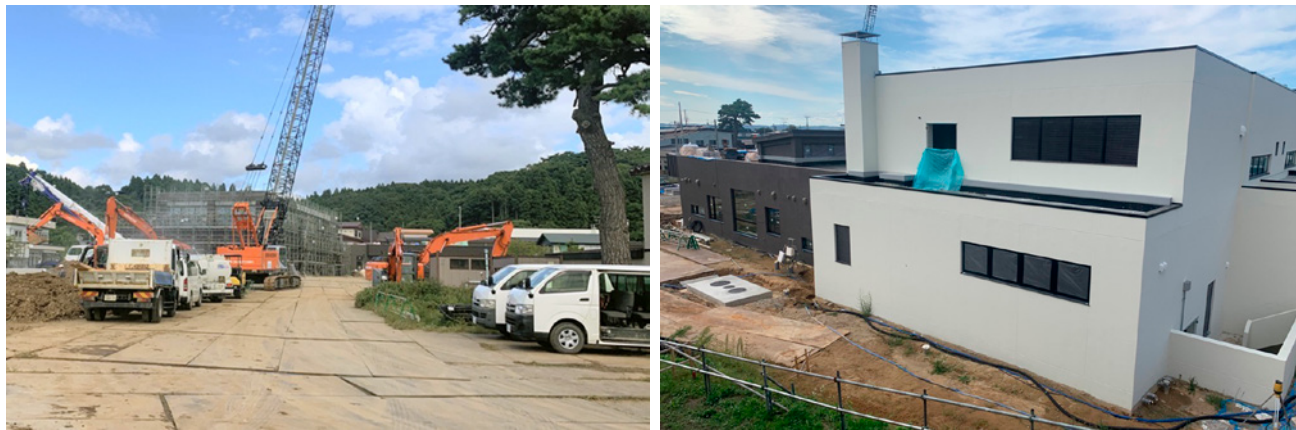
※左は派立商店街通り沿い方向から、右は町防災倉庫沿い方向からの写真（9月26日現在）
