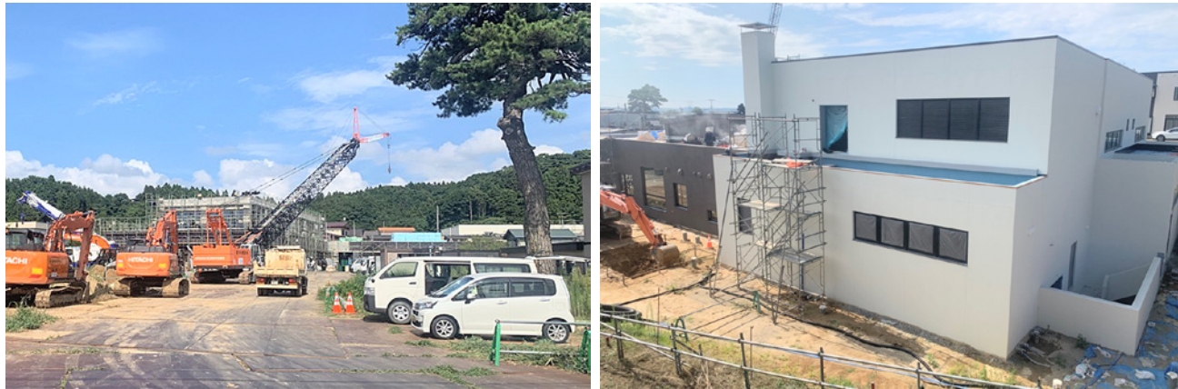
※左は派立商店街通り沿い方向から、右は町防災倉庫沿い方向からの写真（8月21日現在）
