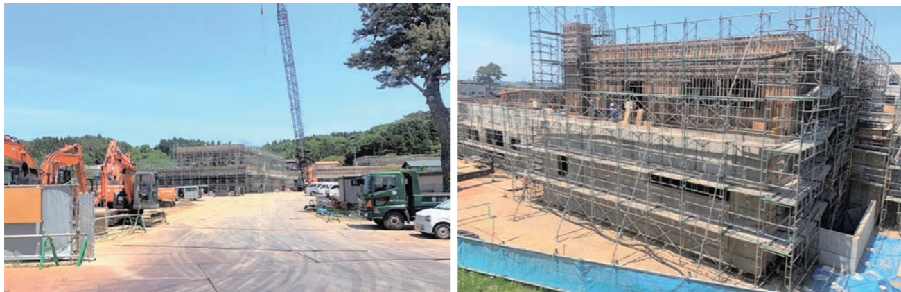
※左は派立商店街通り沿い方向から、右は町防災倉庫沿い方向からの写真（5月25日現在）
