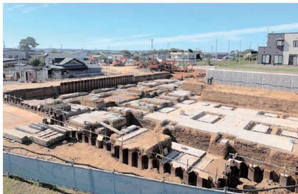
町防災倉庫沿い方向から
