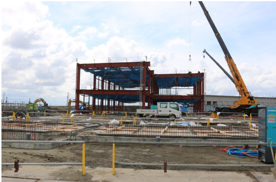
2016年4月11日 新庁舎建設現場(東側)
