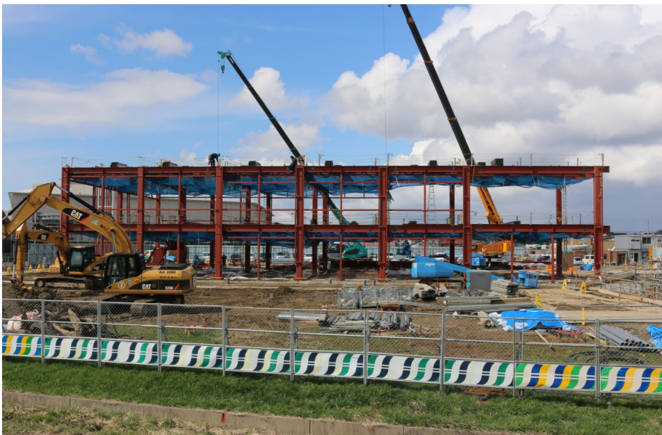
2016年4月11日 新庁舎建設現場(南側)
